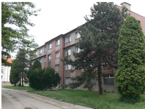
Prostory ELIMu Hranice – v přízemí
