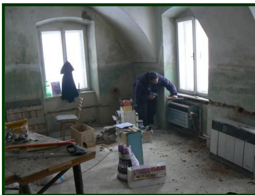
Sekání nové elektriky
